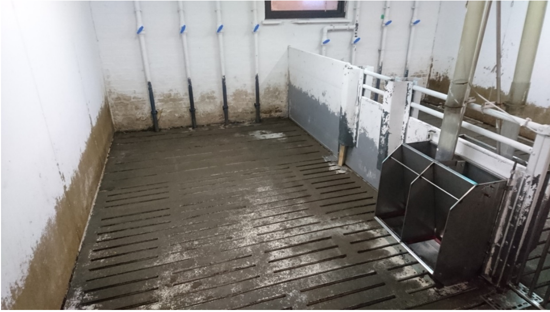
Figur 5. Detoxy-maling påført overflader i staldsektion.
